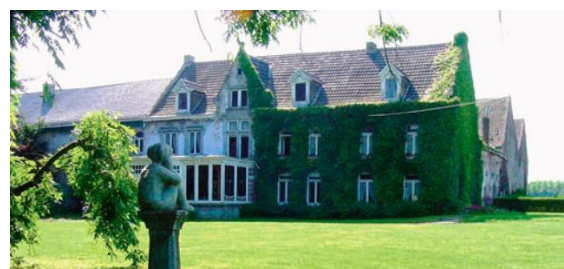
Figuur 9 Het woongedeelte van hoeve Persoons in Ezemaal kreeg in 1907 een facelift: een veranda en drie dakvensters, één uitgewerkt tot een echte puntgevel, herinneren aan de Engelse landhuizen van rond de eeuwwisseling.
